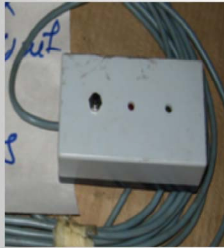
Alarm test button: Code 0065 HUURRE cold room
